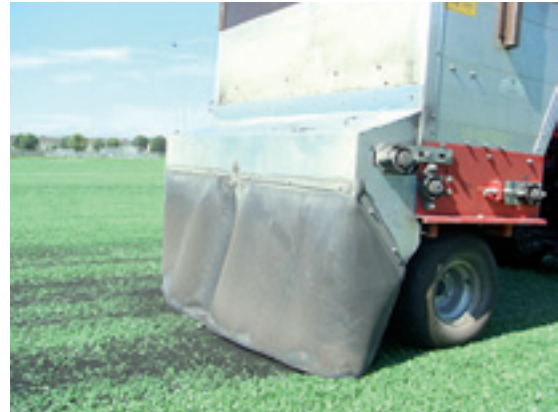
Instrooien rubberinfill met flappen
