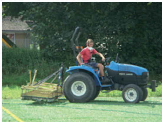
Borstelen/invegen bij aanleg
